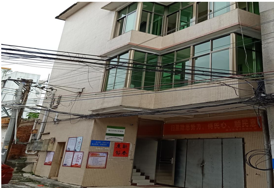
湛江市海头供销社办公楼，地址：湛江市霞山区椹川大道南 50 号。
