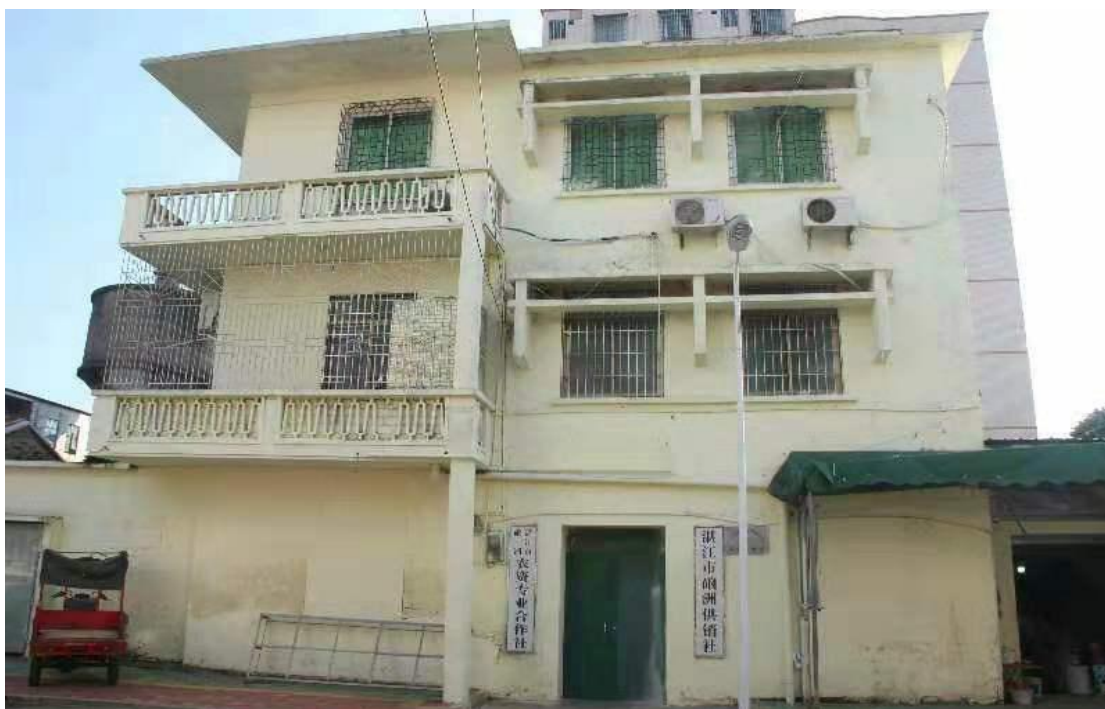
湛江市硃洲供销社办公楼，地址：湛江市硃洲镇人民路 48 号。
