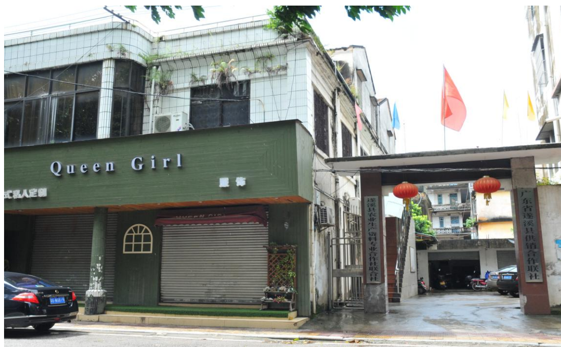
遂溪县供销合作联社办公大楼，地址：广东省遂溪县遂城镇中山路 132 号。
