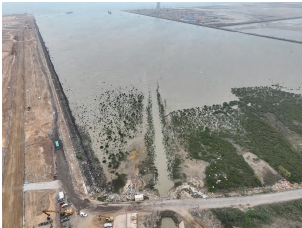
图 3.4.2-2c 东侧雨排#1 附近市政排水口（2022 年 3 月）
