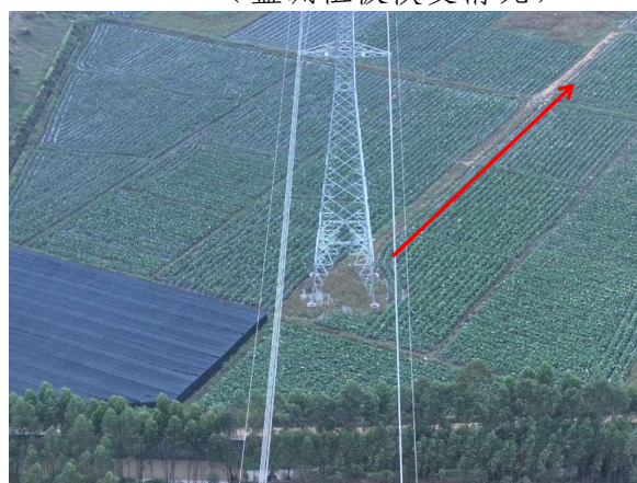
图 1-4 施工道路区监测点 (监测植被恢复情况)
