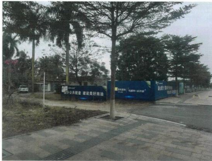
图 4 因道路施工拆除原怡海园大门并围挡围蔽
