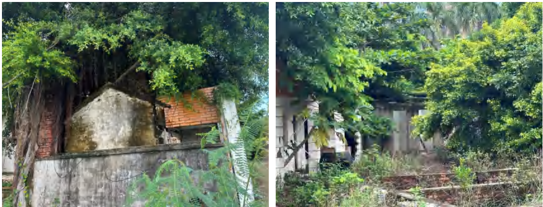
图 1-5 本地块周边建筑情况
