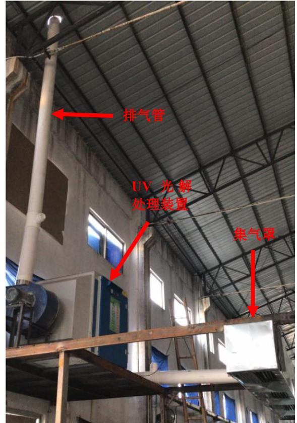
图 6-4 UV 光解处理装置
