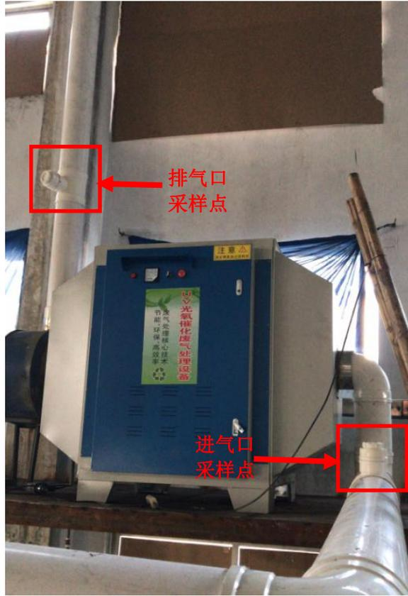
图 6-3 UV 光解处理装置
